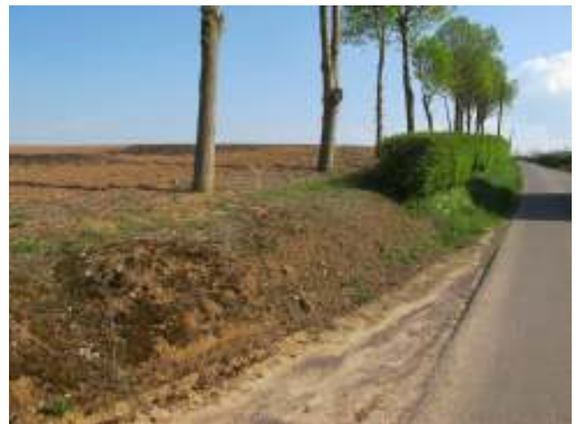
Illustration 11 : talus à Cesny-Bois-Halbout (14)
